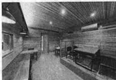
▲ 松谷建築 店舗リフォーム状況
