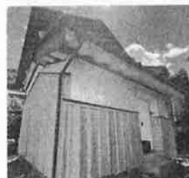
外壁リフォーム
