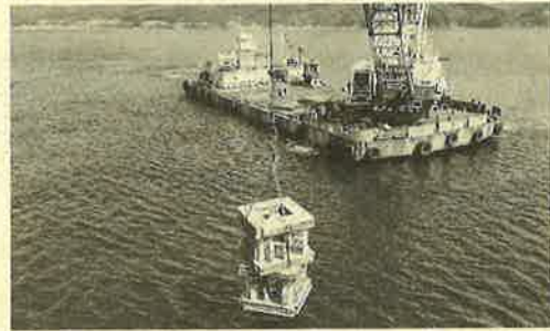
▲ 3月中旬、魚礁の設置状況（河野海岸沖）
