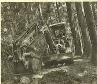
▲ 環境に配慮した作業道の開設
