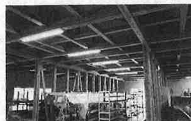
施工事例 (シアターハウス㈱事務所兼倉庫)
