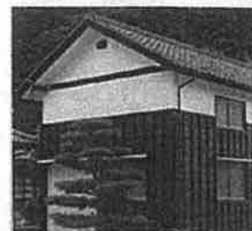
外壁リフォーム
