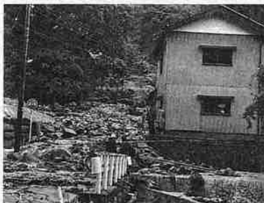
▲山地からの土砂流出状況
