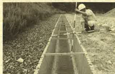
▲排水施設の確認状況
