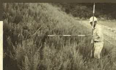
▲盛土の確認状況
