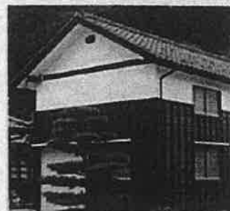
外壁リフォーム
