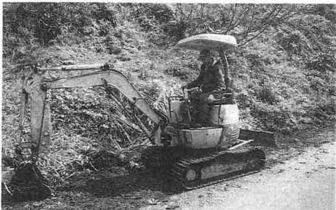
▲ 森林作業道の補修
