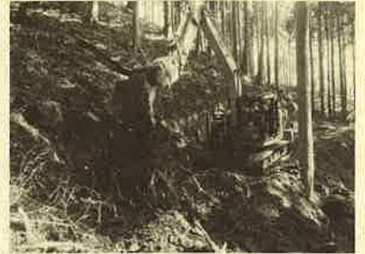
▲グラブで掴んだ「大義バケット」で掘削、伐根処理ができます。
